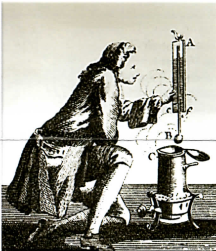
Kalibrierung eines Thermometers am Dampfpunkt
