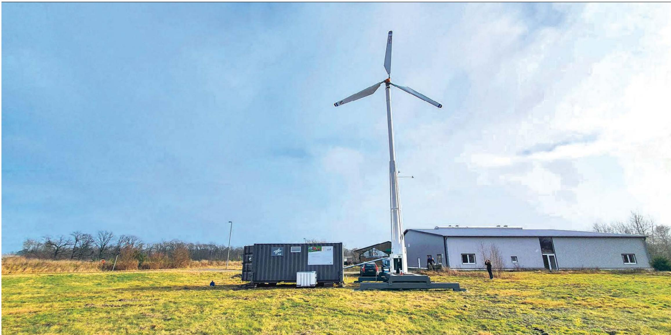
Die Pilotanlage für Windthermie bei Celle besteht aus einem Kleinwindrad und einem Container.
